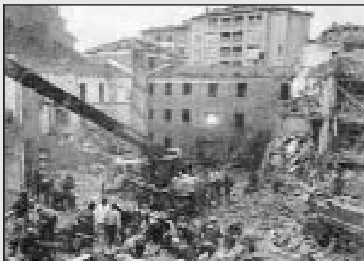
Estado en el que quedó la casa cuartel de Vic.
